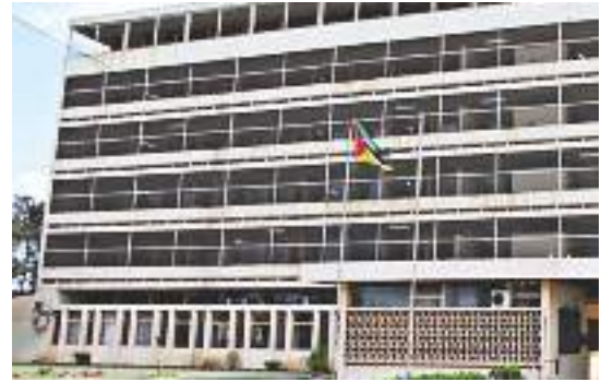
Fig. 6 Hospital Geral da Machava na Província de Maputo
