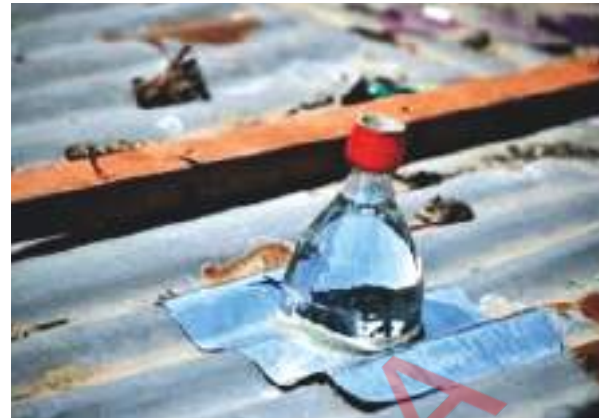
Visão do exterior do telhado
