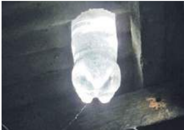
Visão do interior do telhado
